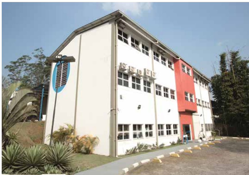
Grupo Byogene centralizou seus departamentos em um único prédio, em São Paulo (SP)
